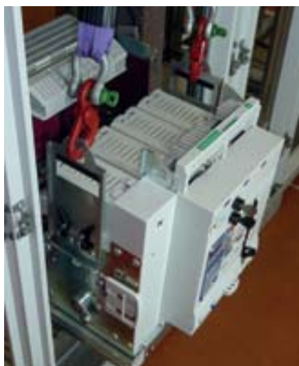
Kikocsizható DMX 3 telepítése a házba.
