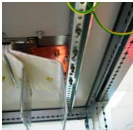
A csatlakozást ezeken a keresztrudakon kell rögzíteni.
