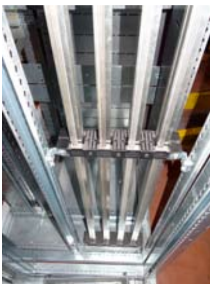
Helyezze be a gyűjtőszíneket, rögzítse őket, majd győződjön meg róla, hogy a helyükön maradnak. (lásd: 27. oldal).
