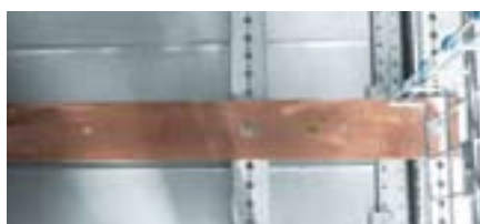
A védővezető egy réz- vagy alumíniumsínből áll
