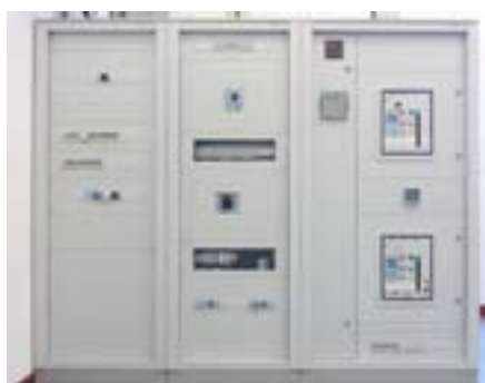
4000 A-es összeállítás DMX 3 forrásváltóval
