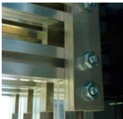
Egy alumínium sín és a dupla fő gyűjtőszín között a kötetést egy alumínium gyűjtőszíndarabbal valósítjuk meg.
