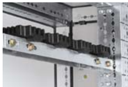
Oldalsó függőleges gyűjtősín belső kábeltojában
