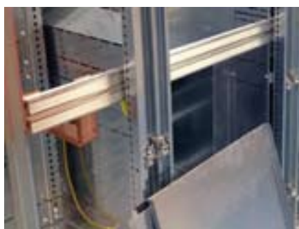
A védővezető egy réz- vagy alumíniumsínből áll
