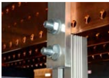
Példa a főgyűjtőszín és egy alumínium gyűjtőszín összekötése a 0 373 82 kat. számú elemmel.
