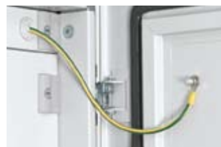
A vezeték átvezetéséhez használjon tömör előlapot Plexo kábelkivezetővel (lásd 15. oldal)
