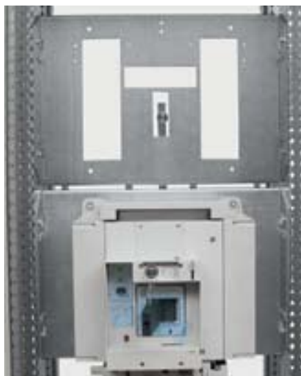
DPX 3 1600 forrásváltó felszerelve
