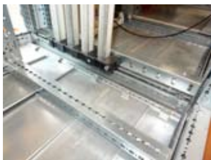
Példa a 0 373 86 kat. számú gyűjtősíntartóra egy 975 mm mély kábeltokban.
