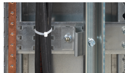
A 0 201 95/96 kat. számú tartókat lapos vagy lépcsős sorkapocs blokk kialakításához használjuk. Alkalmazhatjuk kábeleket, vagy kettőnél több földelő sín rögzítésére.
