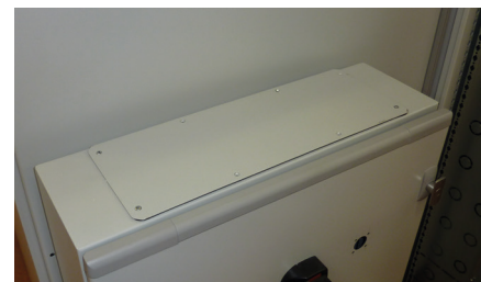
Általános IP 55 védettségű kábelbevezető lemez
