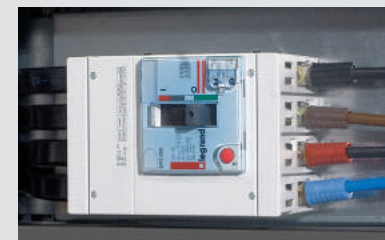
Kábelsarus csatlakoztatás kompakt megszakítónál
