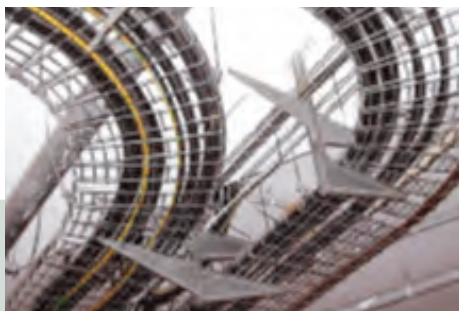
Cablofil wire mesh
