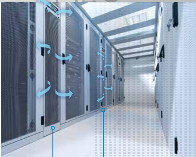
Vizes rendszer hideg levegő áramlása
