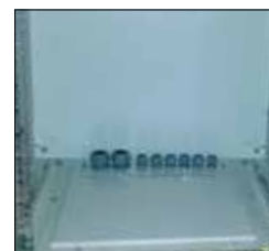
hátsó kábelvezető lap tömszelencékkel
